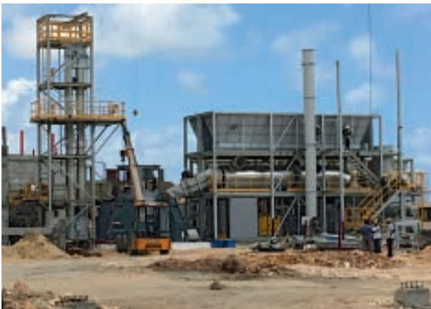
Instalación en construcción
