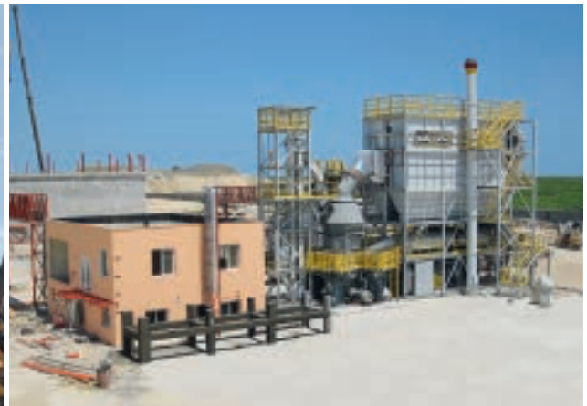
Fin de montaje 2 meses después
